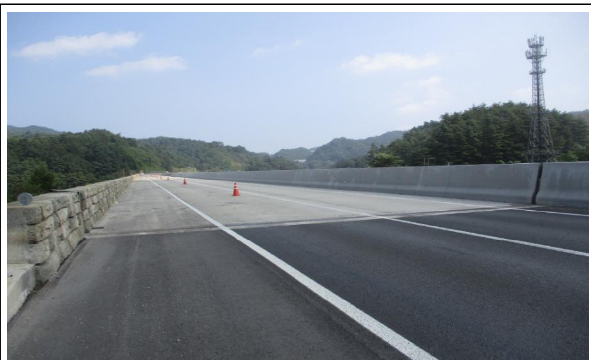
교량 상부 전경
